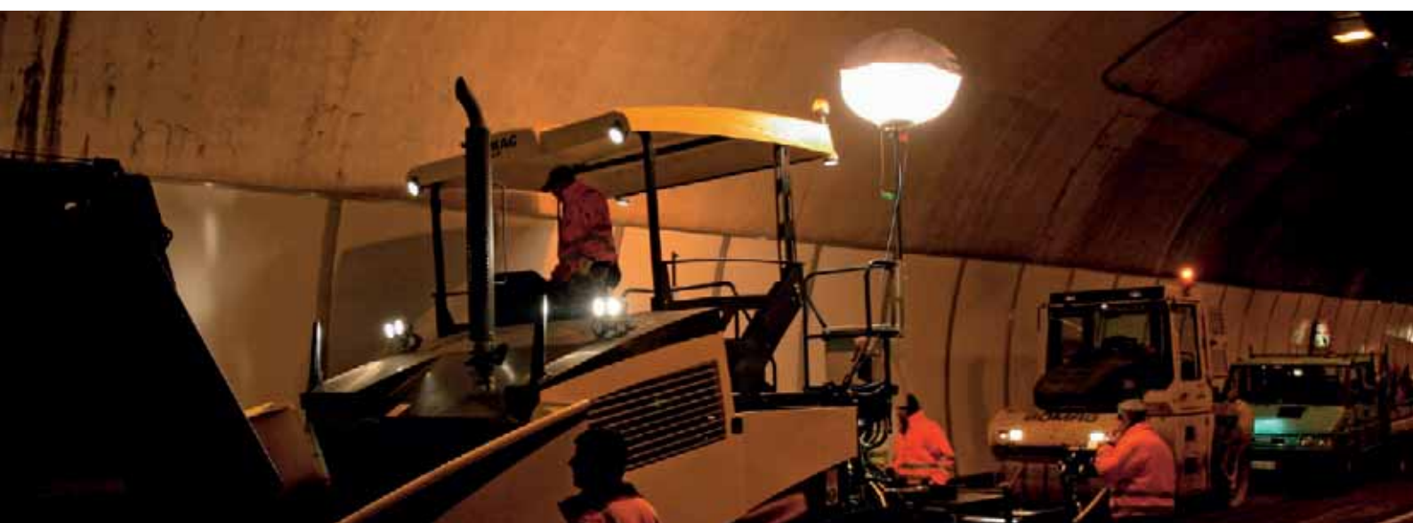
Cantiere notturno con illuminazione BOMAG a 360° con pallone luminoso.
