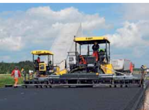
Stesa di base e strato di usura in autostrada.
