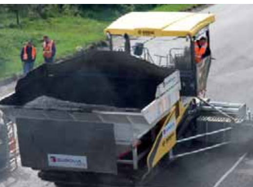
Finitrice con tramoggia supplementare durante la stesa del tappeto in autostrada in Germania.
