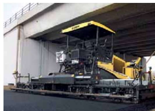
Stesa di una strada principale con una larghezza di 10 m.
