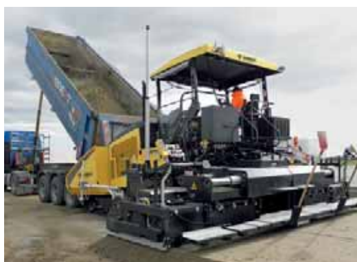
Strato di base cementizia (spessore = cm 28) in cantiere in aeroporto.
