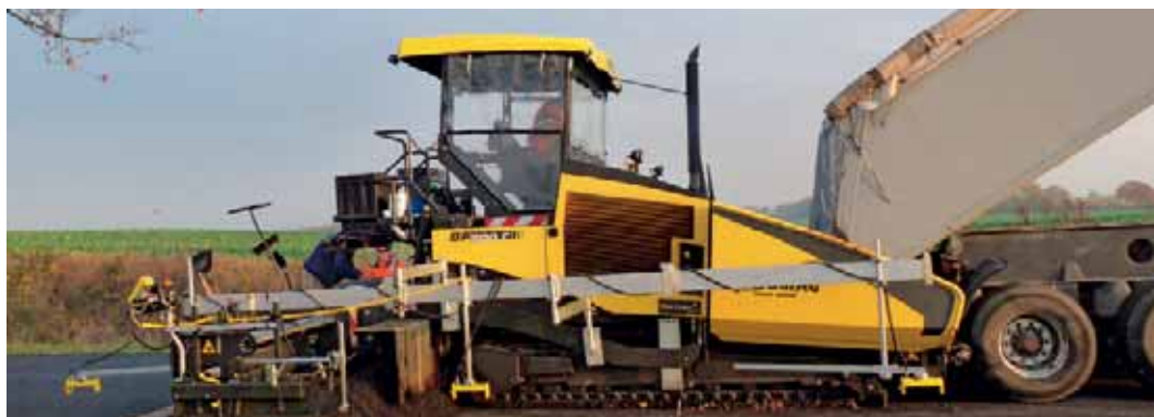
Stesa di uno strato legante con sistema di livellazione Big Sonic Ski.
