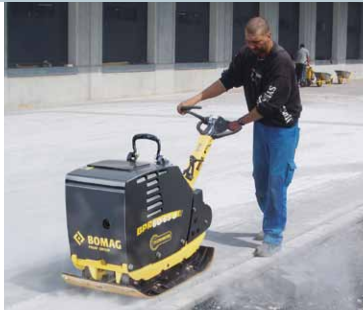
Equipaggiate col tappeto di materiale sintetico (optional) sono particolarmente indicate per lavori su auto-bloccanti.
